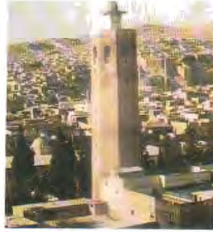
85) Aziz Stefanos Kilisesi çan kulesi (Ulu Camii Minaresi)
