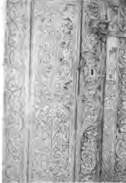
150) Nakipzâde Medresesi kütüphane odası ahşap kapısı
