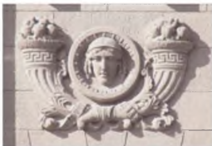
544.18. Фрагменти оздоблення фасаду.
