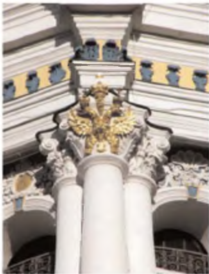
489.1.2. Фрагмент фасаду четвертого ярусу.
