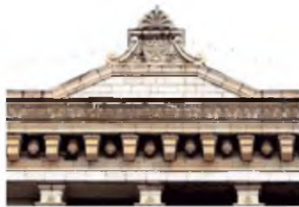
544.16. Фрагменти оздоблення фасаду.
