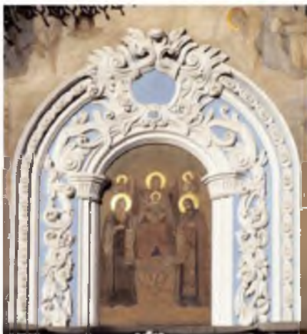
489.1.54. Фрагмент оздоблення західного фасаду.
