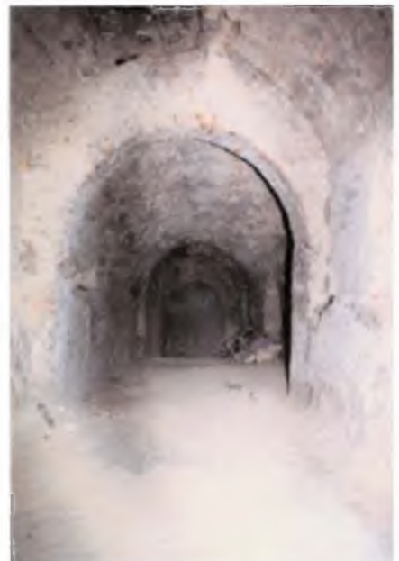
489.1.41. Основне приміщення споруди № 11.
