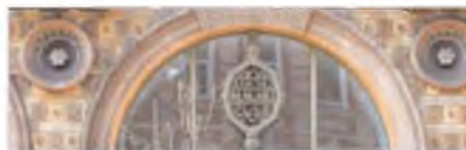
561.12. Фрагменти оздоблення фасаду.
