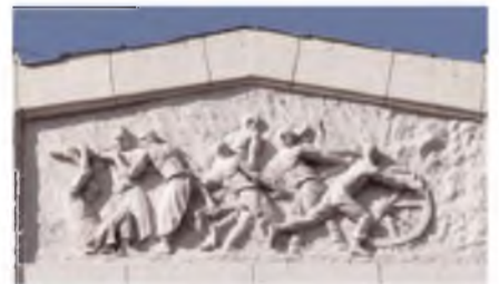
544.17. Фрагменти оздоблення фасаду.
