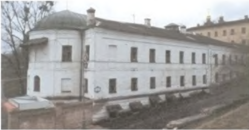
489.3.10. Лікарня прочанська з церквою Всіх скорботних Радість, 19 ст. (архіт.). Корпус № 68. У північній частині Гостиного двору, вздовж узвозу до Ближніх і Дальніх печер. Первісно споруджена як двоповерхова за проектом арх. П. Спарро в 1848—50. За проектом військового інж. О. Середи 1859, затвердженим у травні 1860, до східного фасаду в 1864—66 прибудовано апсиду теплої церкви, до західного — додаткові приміщення для хворих. У грудні 1866 храм освячено в ім'я ікони Божої Матері «Всіх скорботних Радість». 1899 за проектом арх. В. Ніколаєва надбудовано третій поверх. На першому розміщувалися житлові кімнати майстрів і робітників, які працювали в Лаврі. Церква займала другий поверх циліндричного східного об'єму. Конху було увінчано двома верхами з позолоченими маківками та хрестами, оздобленими кольоровим склом. Храм освітлювався через шість вікон. Стіни та склепіння розписали лаврські майстри. У вівтарі зберігався великий срібний хрест з частками Хреста Господнього та мощей Григорія Богослова, Іоанна Златоуста, апостола Андрія Первозванного, сорока мучеників, Ніла Афонського, Дмитрія Солунського і часткою дерева від труни преп. Сергія Радонезького. У південній частині церкви стояла дерев'яна з позолоченими банями модель собору Успіння Пресвятої Богородиці. 1867 майстер І. Осмоловський виготовив різьблений дерев'яний іконостас, кіоти та жертівники. Царські врата й кіоти було позолочено (все втрачено). Лікарня, що складалася з чоловічого та жіночого відділень, щорічно обслуговувала до 500 хворих, мала окрему кухню та допоміжні приміщення. Утримувалася, в основному, за рахунок благодійних внесків. Після спорудження 1912 нової лікарні (корпус № 111) в будинку розміщено богадільню. 1918 прочанську лікарню повернено на старе місце (корпус № 68). 11 червня 1920 під час артилерійського обстрілу церкву пошкоджено снарядами. 1921, на вимогу воєнкому 2-го Київського військового шпиталю, закрито. Після націоналізації споруда перебувала у віданні Соцзабезу. У повоєнні роки будинок використовувався як житловий, згодом — як виробничий. У 1980-х рр. та 2006—07 проведено капітальні ремонти. Дво-, триповерховий на цокольному поверсі, цегляний, пофарбований, у
