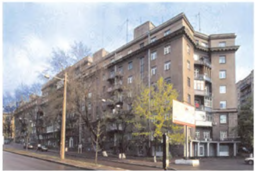
521.13. Вул. Л. Толстого, 25/2—25/18.
