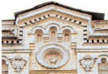
576.22. Фрагменти оздоблення фасаду.
