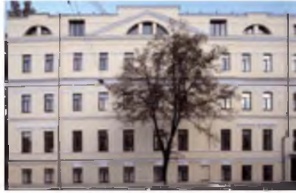
540.2. Вул. Ігоревська, 14. 540.2. Вул. Ігоревська, 14. Прибудова.
