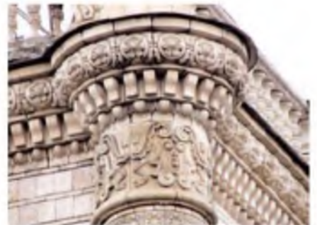
544.6. Фрагменти оздоблення фасаду.
