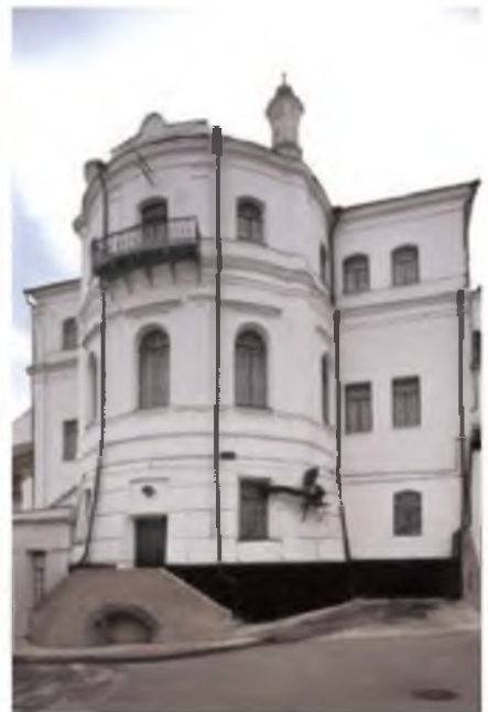
489.1.14. Фрагмент східного фасаду.
