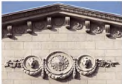
544.18. Фрагменти оздоблення фасаду.
