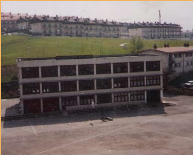
Eskolaren itxura 1988an, lanen aurretik. Aspecto del colegio en 1988, antes de la obra.
